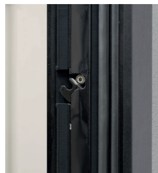
Der Verschluss mit pferdekopfförmiger Verriegelung im Rahmen
